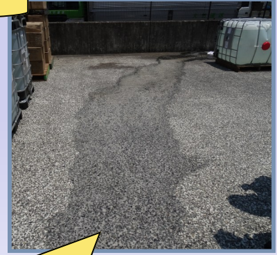
漏洩物が路面に広がり汚染してしまった…
